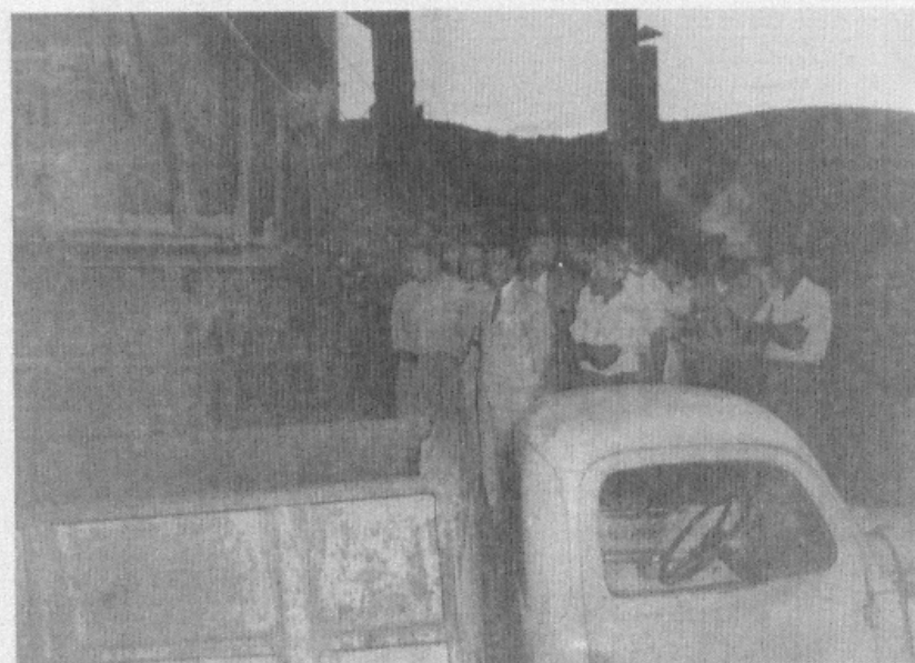
Juscelino acompanha as obras da estrada Rio-Juiz de Fora-Belo Horizonte. s.l., 9 de março de 1956. Agência Nacional
