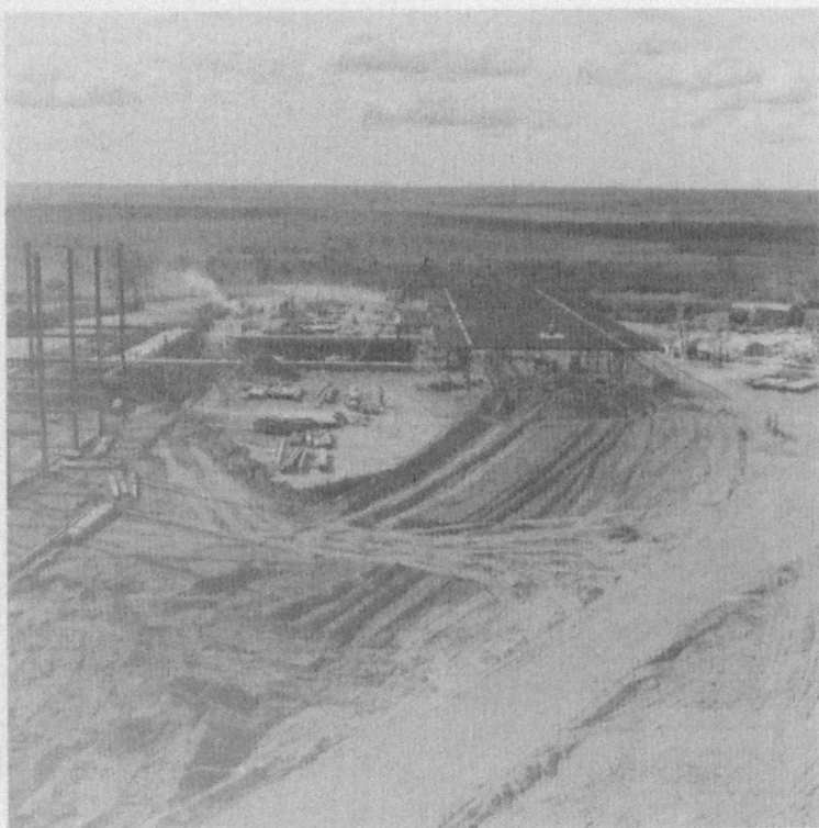
Canteiro de obras em Brasília. 7 de julho de 1957. Agência Nacional
