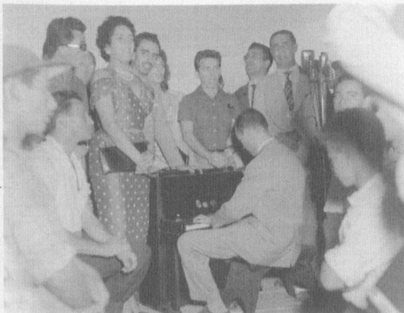
Serestas na futura capital durante visita de JK às obras. Brasília, 17 de dezembro de 1957. Agência Nacional
