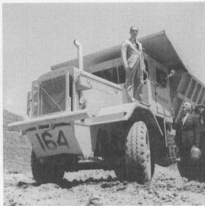
JK vistoria obras em Furnas acompanhado de Lúcio Meira, presidente do BNDE. Minas Gerais, 17 de outubro de 1959. Agência Nacional.
